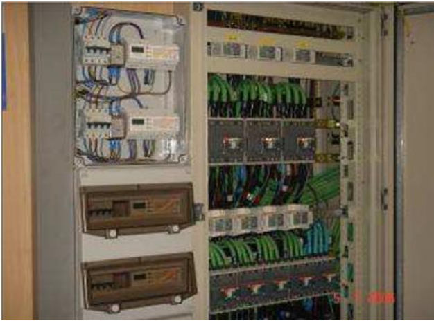
GECE gestionando los consumos eléctricos en diversas zonas de un edificio: Aviso de incidencias, contador de energía, limitador de sobrecargas, ... etc.
