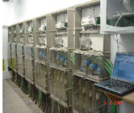
GECE gestionando los consumos eléctricos en diversas zonas de un edificio: Aviso de incidencias, contador de energía, limitador de sobrecargas, ... etc.
